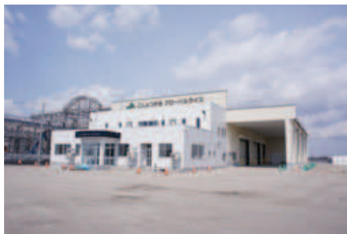
完成した精米施設（4月25日、五所川原市梅田地区で）
